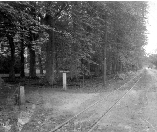
Tramrails ter hoogte van Hoekendaal (ca. 1920)
